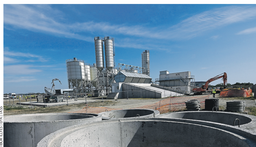
Венгрия импортирует почти половину потребляемой электроэнергии, поэтому строительство АЭС «Пакш-2» (на фото) стране крайне необходимо
