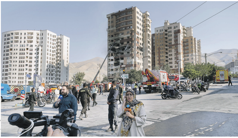
Разрушенный в результате израильского авиаудара жилой дом в Тегеране
