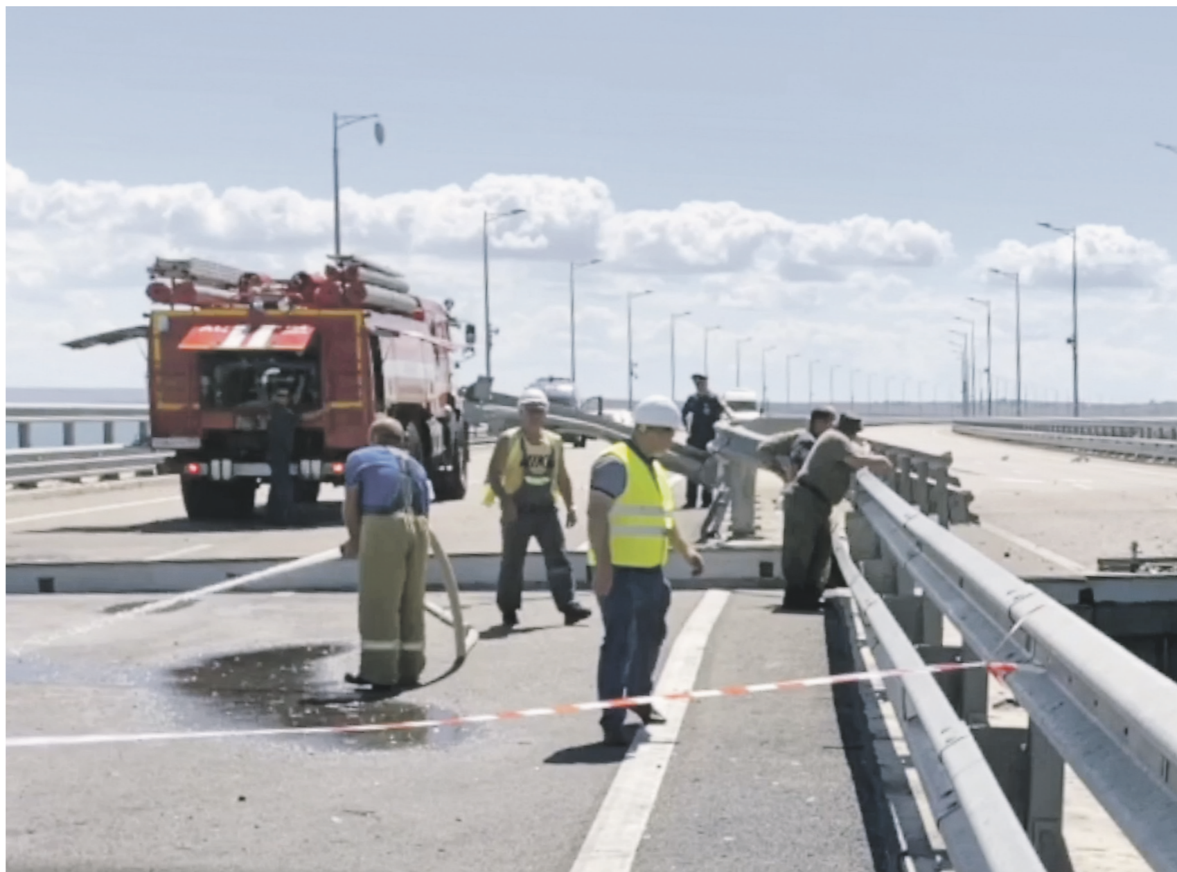
На Крымский мост оперативно прибыли специалисты по проведению ремонтных работ
