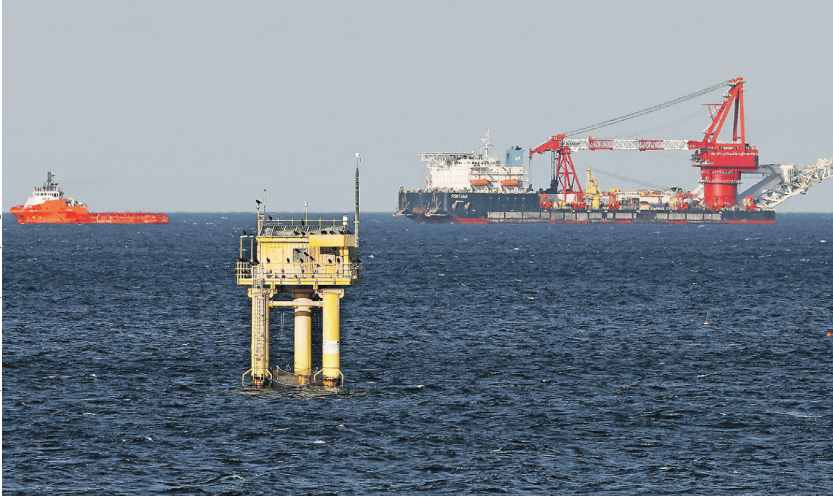
Строительство СП-2 завершится уже в августе, а к концу года газопровод начнёт работу
